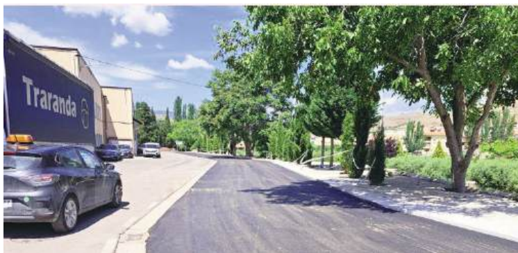
Finalizados los trabajos de mejor del firme en Brea.
